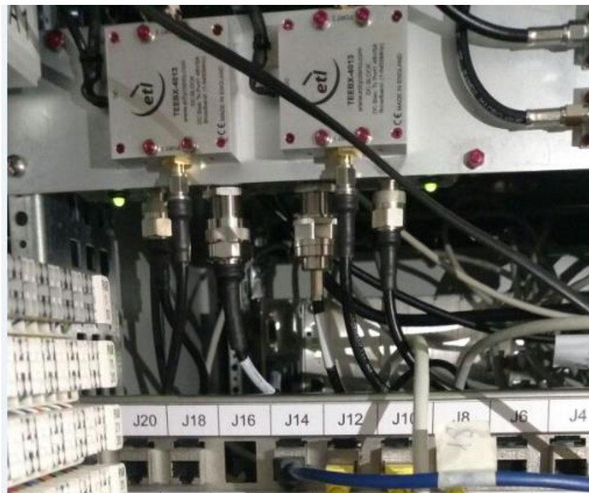
Esta imagen muestra que el DC Block anterior fue retirado
